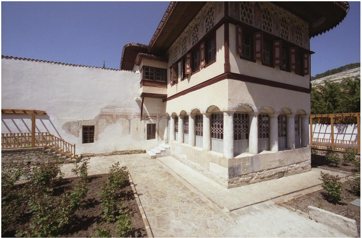
Рис. 6. Колонны Летней беседки (фото Н. В. Днепровского)
